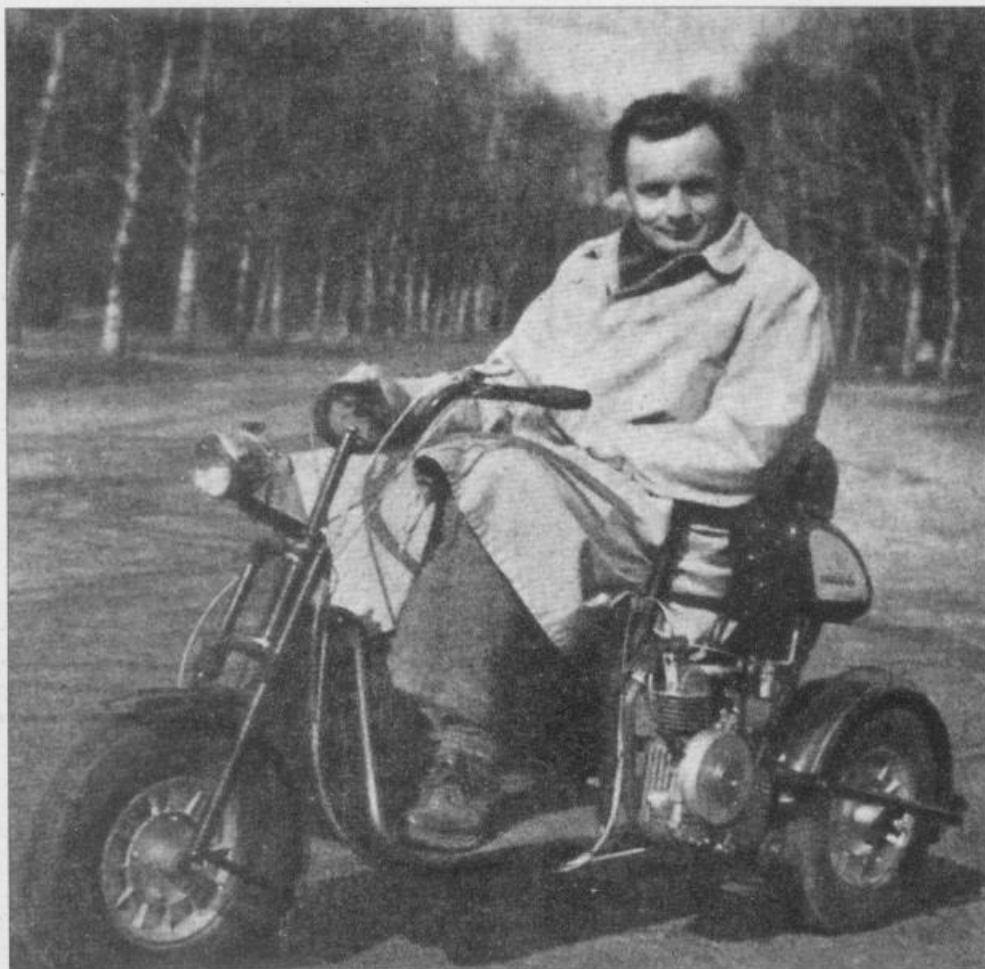
Tříkolka pro invalidy, postavená u firmy Juban podle návrhů ing. Hausmanna (pan Juban za říditky)
